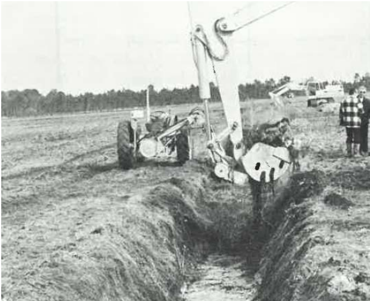
Figure 9 : Création de fossés d'assainissement, Ref. 10
